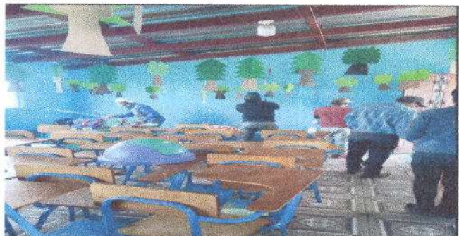
Foto 6: Pintada de paredes
