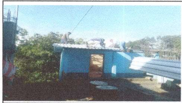
Foto 2: Techado de cocina escolar
