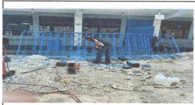
Foto 4: Fabricacion de Balcones
