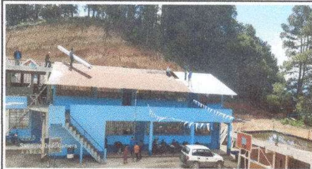
Foto 3: Techado de aulas
